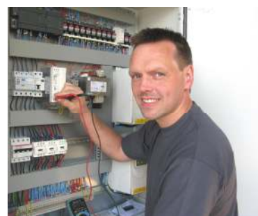
Tommy Kirkegaard: der er store gevinster at hente ved at optimere ældre ventilationsanlæg
