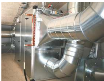
Aggregat til rumventilation
