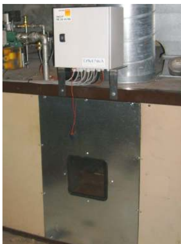
Ny enhed med direkte gasbrændere monteret i gammel sprøjte-/tørrekabine
