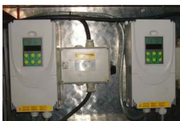
Frekvensomformere regulerer luften i Davenka Energisparepakke. Dermed bruges kun den energi, der er behov for
