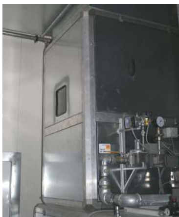
Brænderenhed med Davenka Energisparepakke med direkte gasfyring
