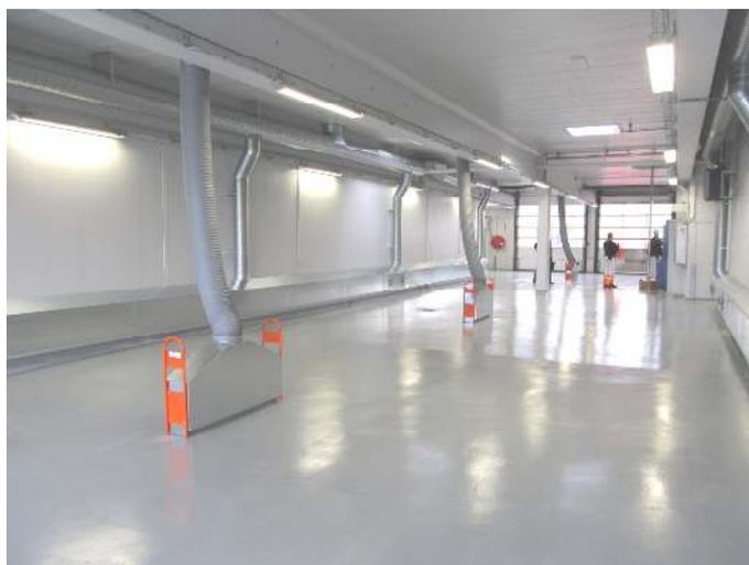
Der er monteret sugekasser på sidevæggene. I sugekasserne er der placeret udsugningssektioner, hvor udsugningen foregår. Disse udsugningssektioner kan flyttes efter behov, således at udsugningen sker direkte ved bilernes udstødning for at sikre effektiv udsugning af de skadelige stoffer fra udstødningsrøgen.
